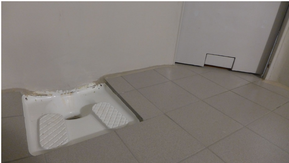
Toalett på sikkerhetscellen og gulvluke som ble brukt til utdeling av mat og drikke.
