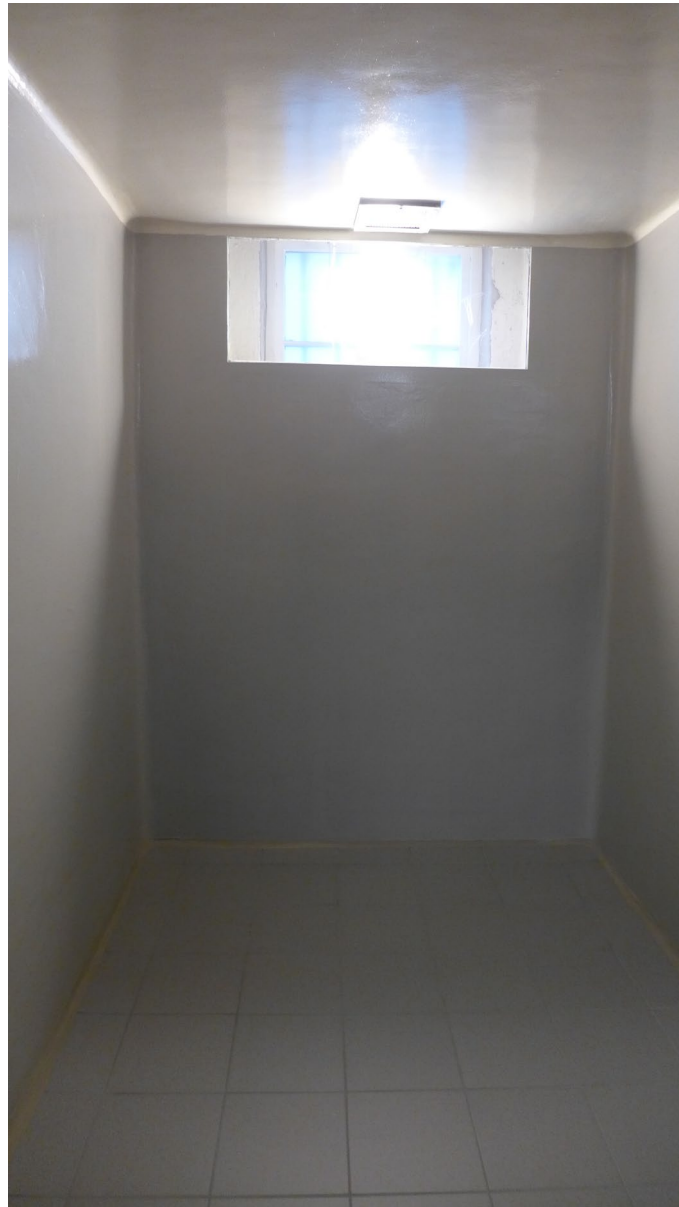
Vindu på sikkerhetscelle med lampe. Begrenset kontrastfarge mellom gulv og vegg.
